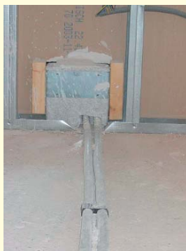
Пример: подключение от встраиваемых распределителей ГЕРЦ
